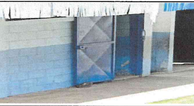
Foto 5: Sustitución de chapa
