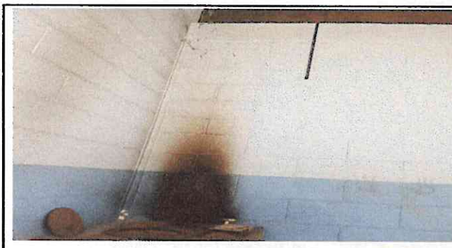
Foto 3: área para la construcción de chimenea de ladrillo.
