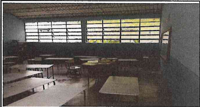
Foto 4: mantenimiento y sustitución de vidrio en ventana parte trasera del salón 3.
