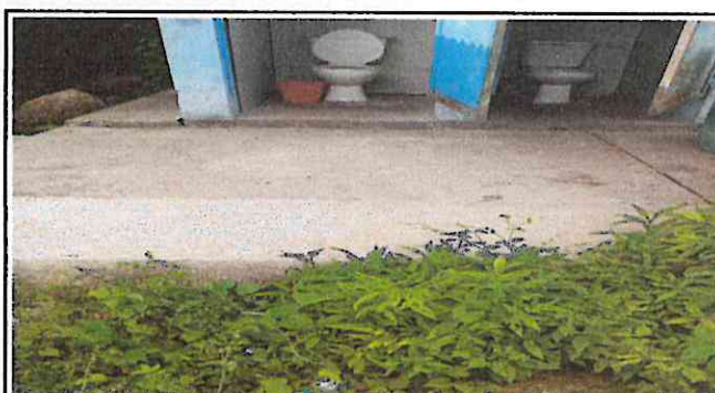
Foto 4: Sustitución de inodoros, Reparación de red de drenajes: sustitución de la tubería de pvc líneas principales de aguas negras de cada sanitario.
