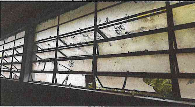
Foto 3: mantenimiento y sustitución de vidrio al frente de salón 3 e implementación de balcón.
