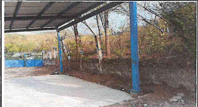
Foto 2: sustitución del muro perimetral de block con columnas intermedias y malla de 1 metro.
